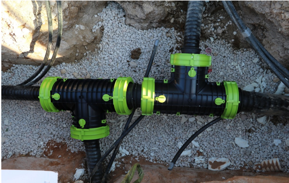
T-Stück im offenen Graben
