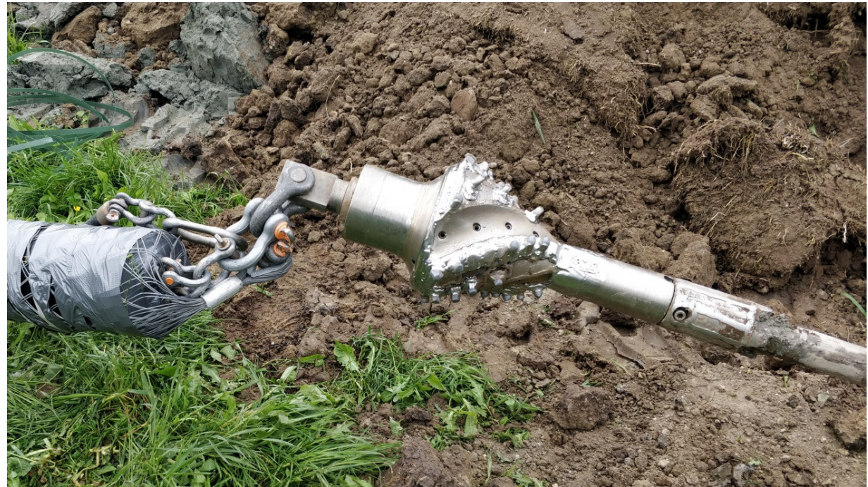
Grabenlose Verlegung im günstigen Spülbohrverfahren
